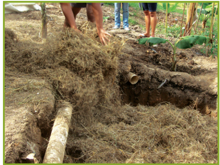
Imagem 8: Preenchimento da vala com capim seco
