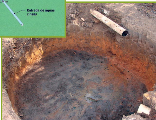
Imagem 2: Vala aberta sem preenchimento
