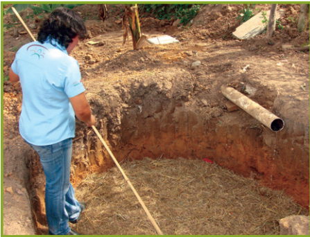
Imagem 7: Preenchimento da vala com capim seco
