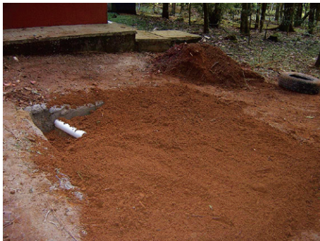
Imagem 13: Preenchimento com camada de solo
