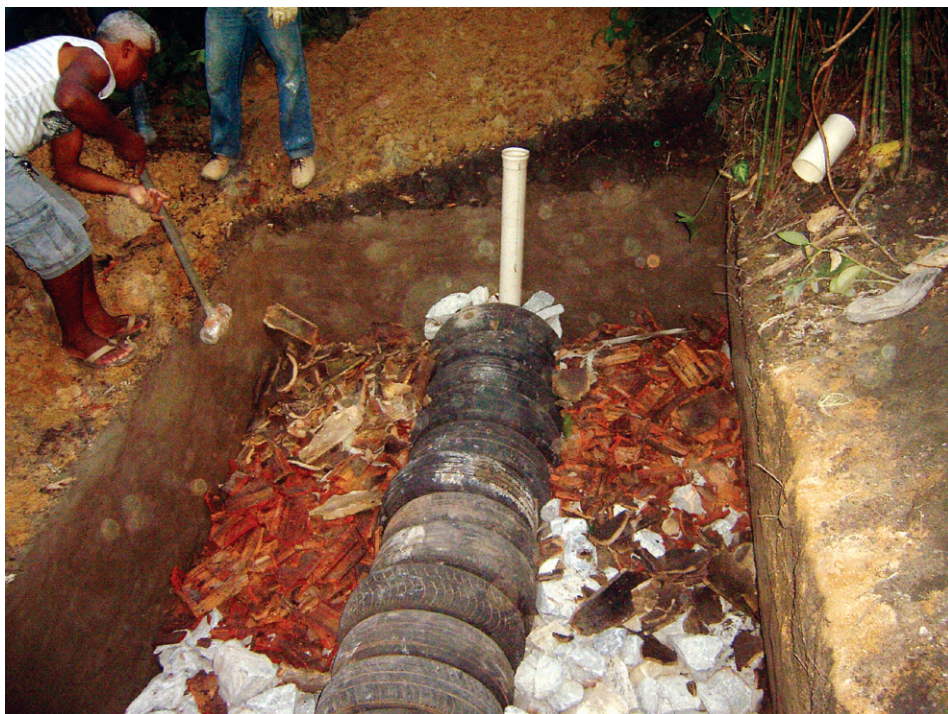
Imagem 9: Preenchimento da câmara anaeróbia com camada de entulhos
