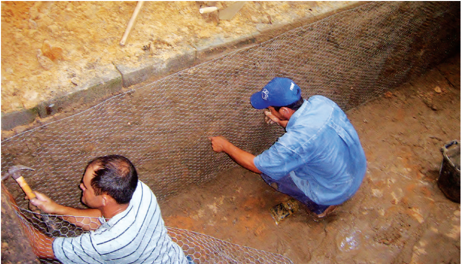
Imagem 5: Utilização da técnica de ferrocimento
