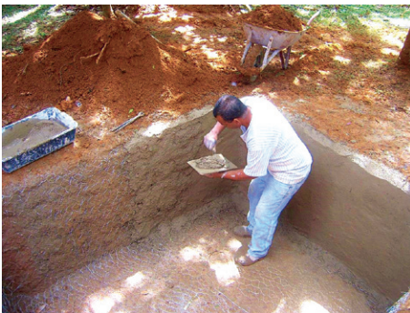
Imagem 6: Utilização da técnica de ferrocimento
