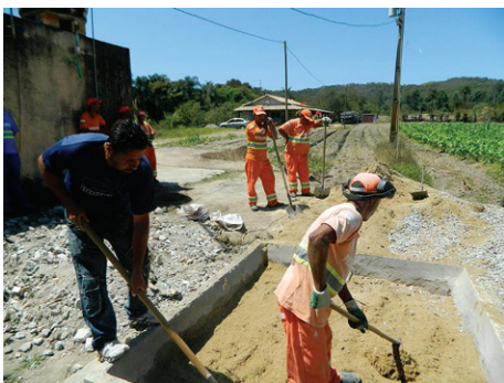
Imagem 12: Preenchimento com a camada de areia
