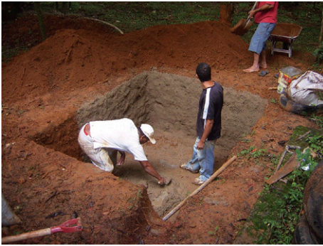
Imagem 2: Impermeabilização das paredes e fundo do Tevap
