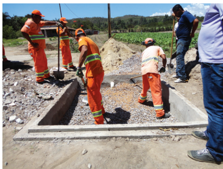
Imagem 11: Preenchimento com camada de brita
