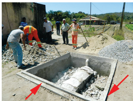
Imagem 16: Proteção contra o escoamento superficial
