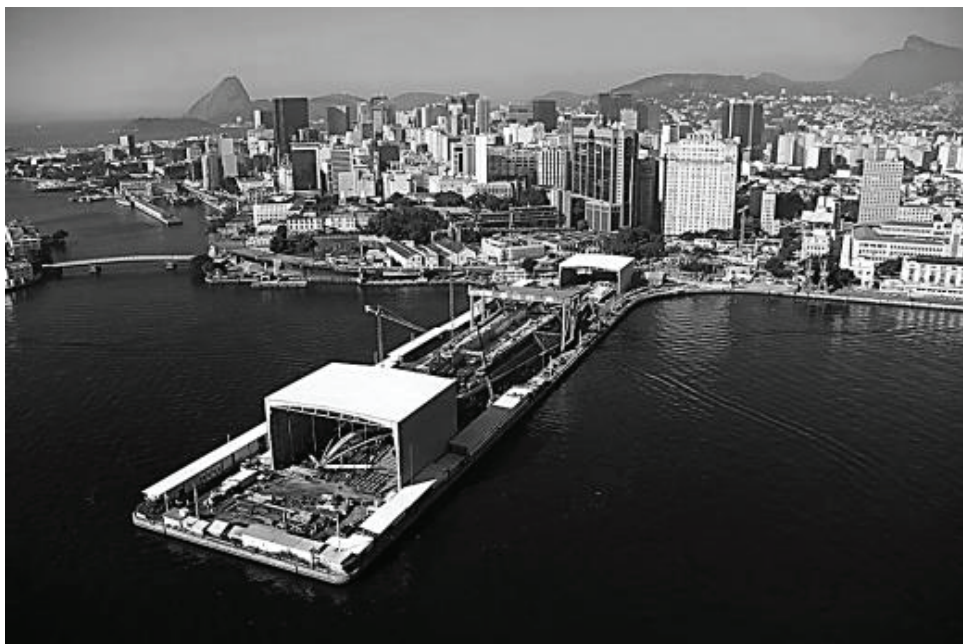
Figura 4 – Etapa da Obra – Julho 2014
