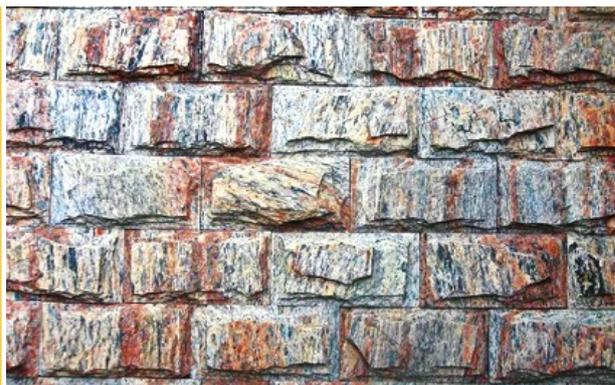
PAREDES - Revestimento sintético tridimensional, com acabamento em pintura ou natural.
