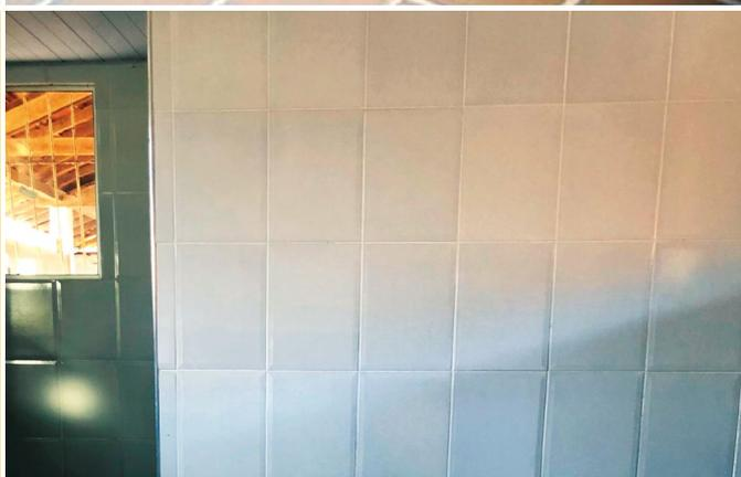
Forros em PVC na cor branca, impermeáveis e laváveis, ou laje de concreto com acabamento em pintura lavável na cor branca. (Forro em madeira não é permitido)
