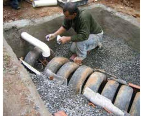
Foto 6 – Instalação do cano de entrada do esgoto
