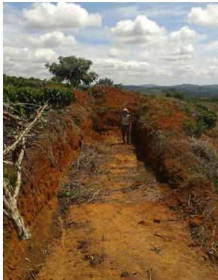
*Bacia retangular construída na largura da pá carregadeira para facilitar a manutenção.*
