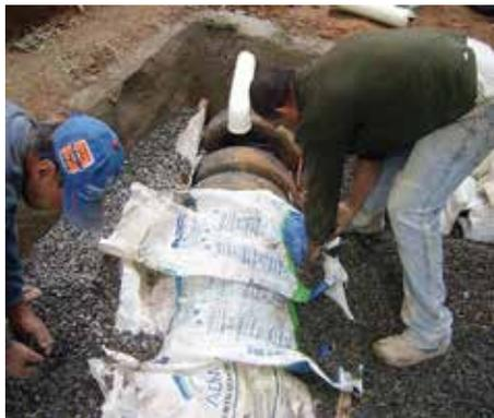
Foto 7 – Vedação superior da câmara de fermentação para colocação da camada de areia
