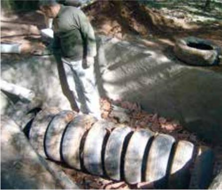
Foto 4 – Câmara de fermentação construída com pneus
